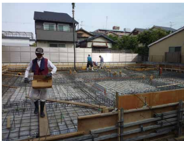
伝統工法を使う建物にも、基礎にはコンクリートを打設すること も多い。
