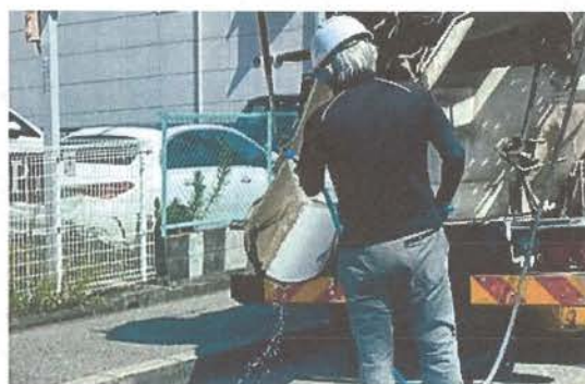
路上で洗浄する生コン運転手
